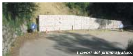
I lavori del primo stralcio.
